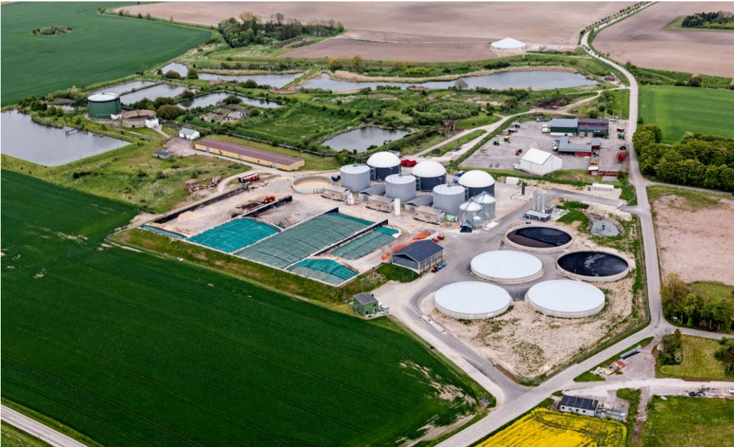
Bild 1. Flygbild över Gasum Jordberga AB. Sedan flygbilden togs har lakvattenbrunnen och de två biogödselbehållarna utan täckning på bilden försetts med tak samt betongvägg och bullervall runt uppgraderingen i syd- och västligt läge byggts.
